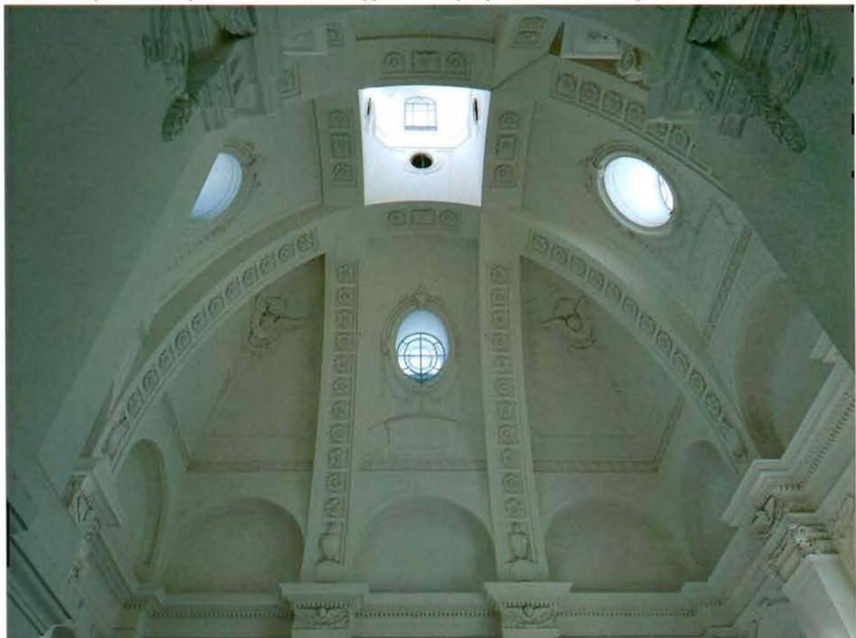
8. Сомкнутый свод усыпальницы, подпружные перекрещивающиеся арки.
